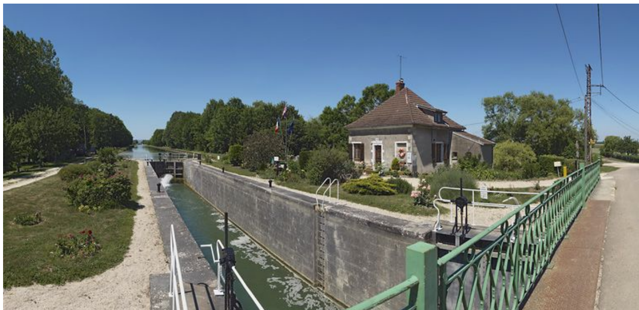
Le site vu d'aval.
