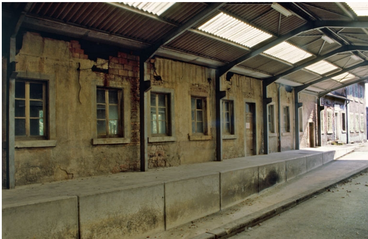
Quai couvert établi contre l'ancien tissage.
