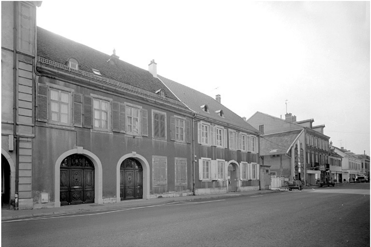
Vue d'ensemble avec la maison n° 63.
