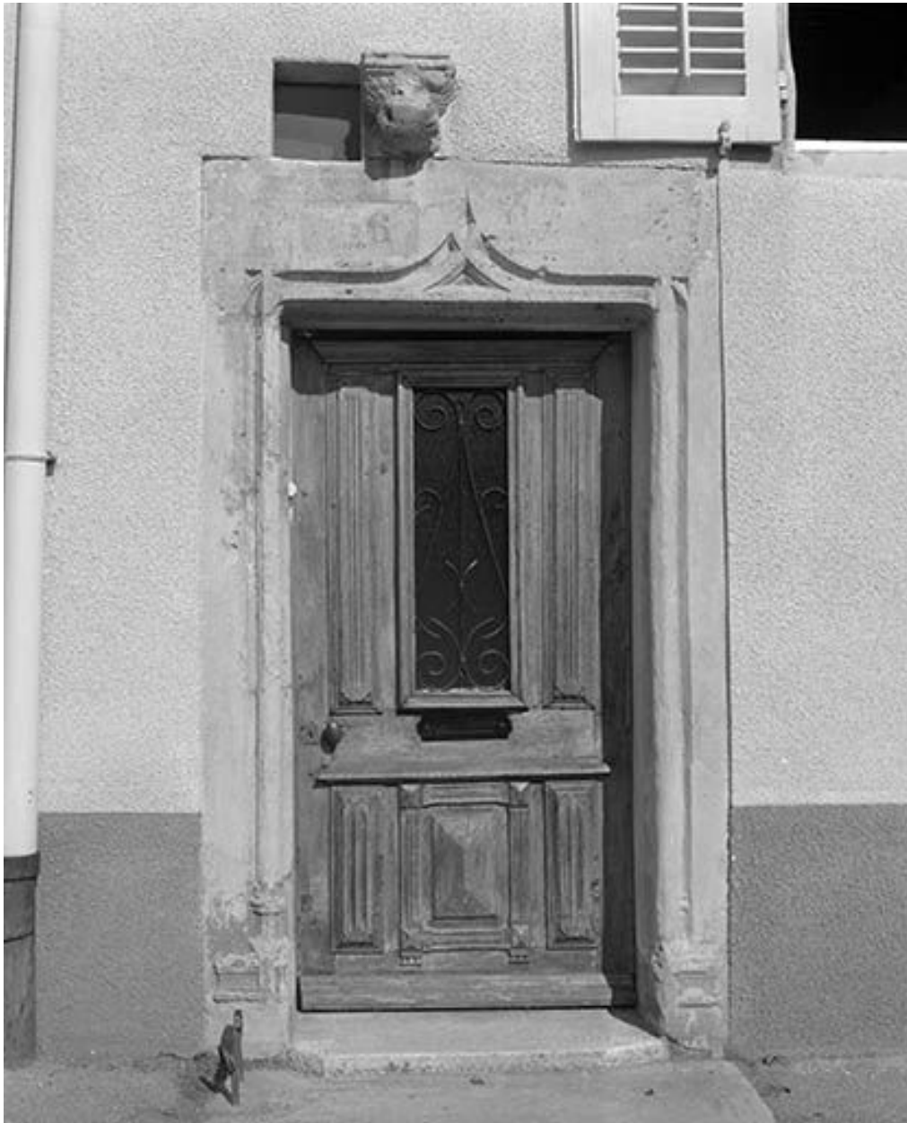
Maison située route de HautePierre, cadastrée 1971 AB 529 : porte piétonne.
