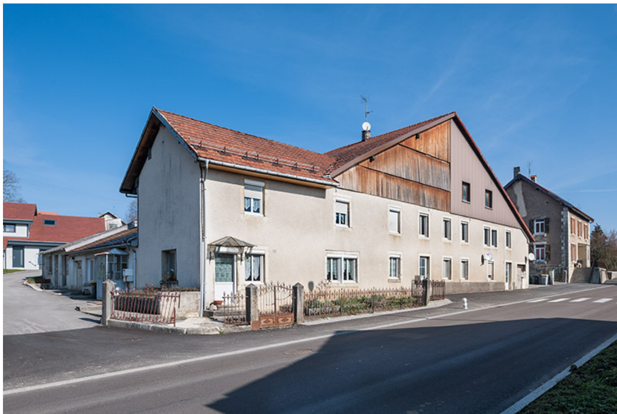
Ferme : façade antérieure, de trois quarts gauche.
