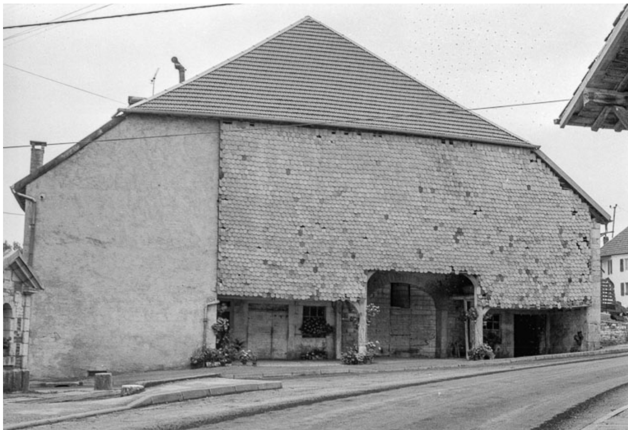
Façade latérale droite sur rue.
