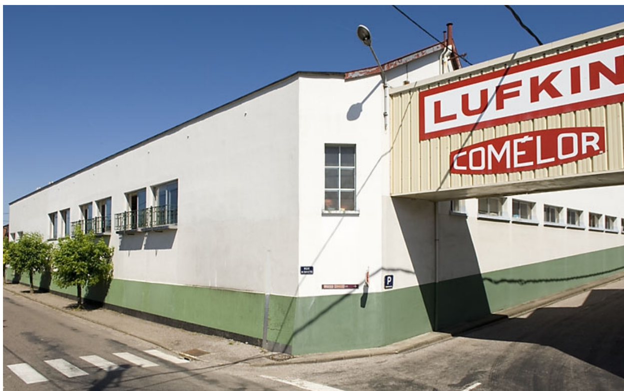
Façades des ateliers ouest.
