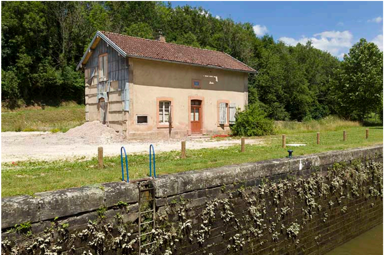
La maison d'éclusier, depuis l'écluse.
