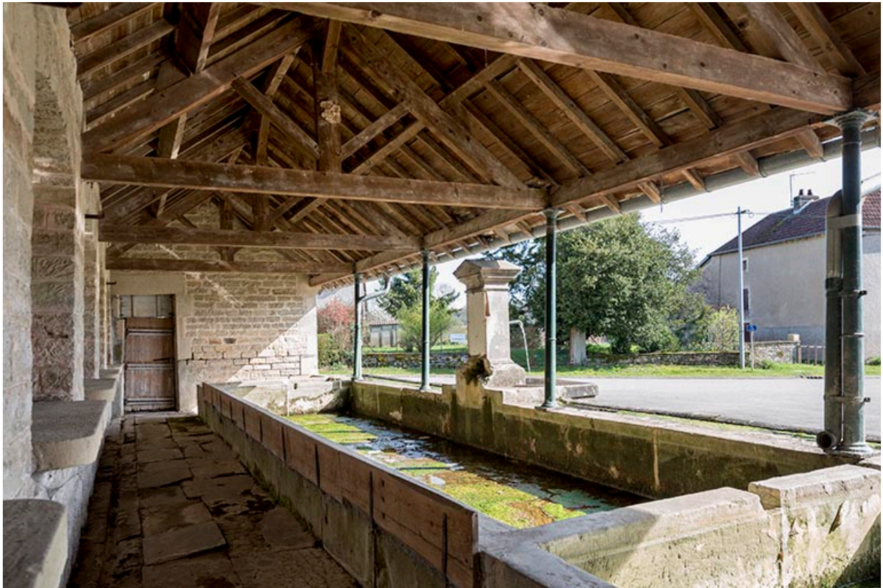
Fontaine-lavoir à l'angle de la Grande rue et de la rue du Bas : vue intérieure depuis le nord-ouest.
