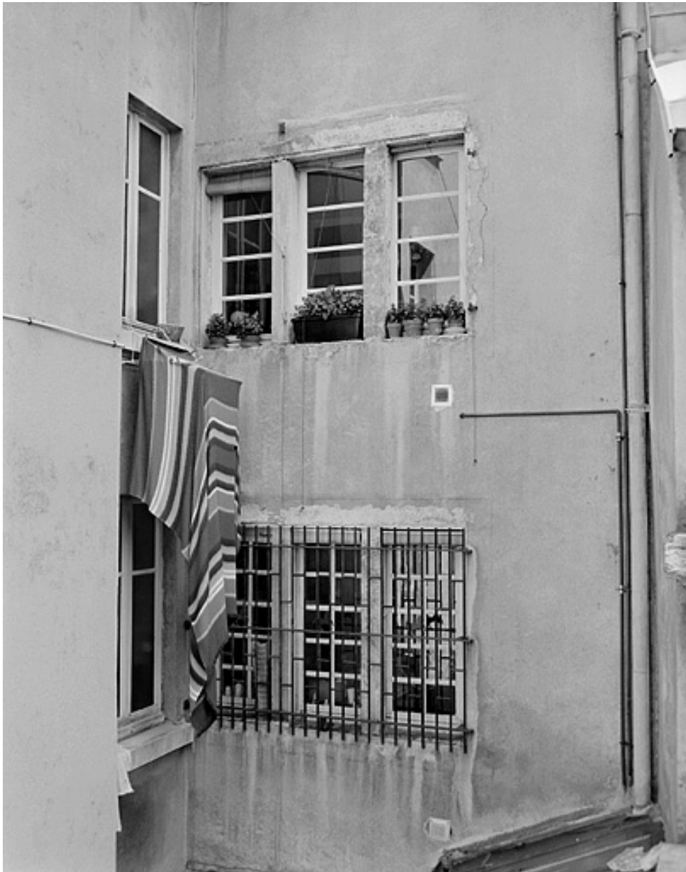
Maison 17, rue des Febvres. Façade sur cour du premier corps de bâtiment. Deuxième moitié 17e siècle.
