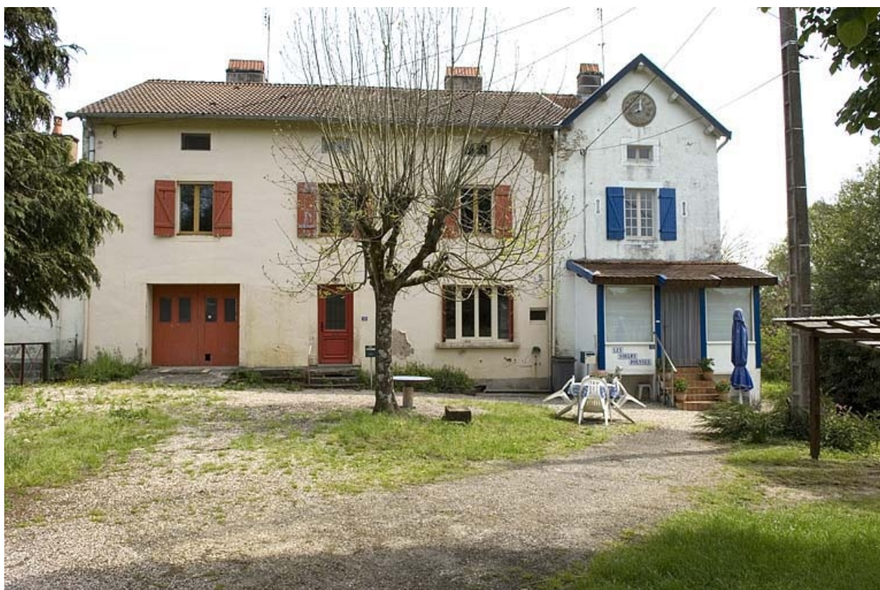
Logement de la centrale hydroélectrique.
