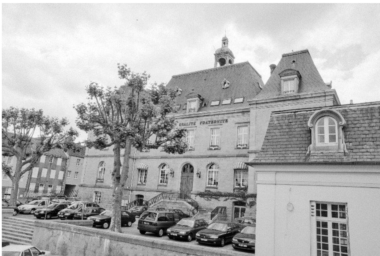
Façade antérieure de l'hôtel de ville.
