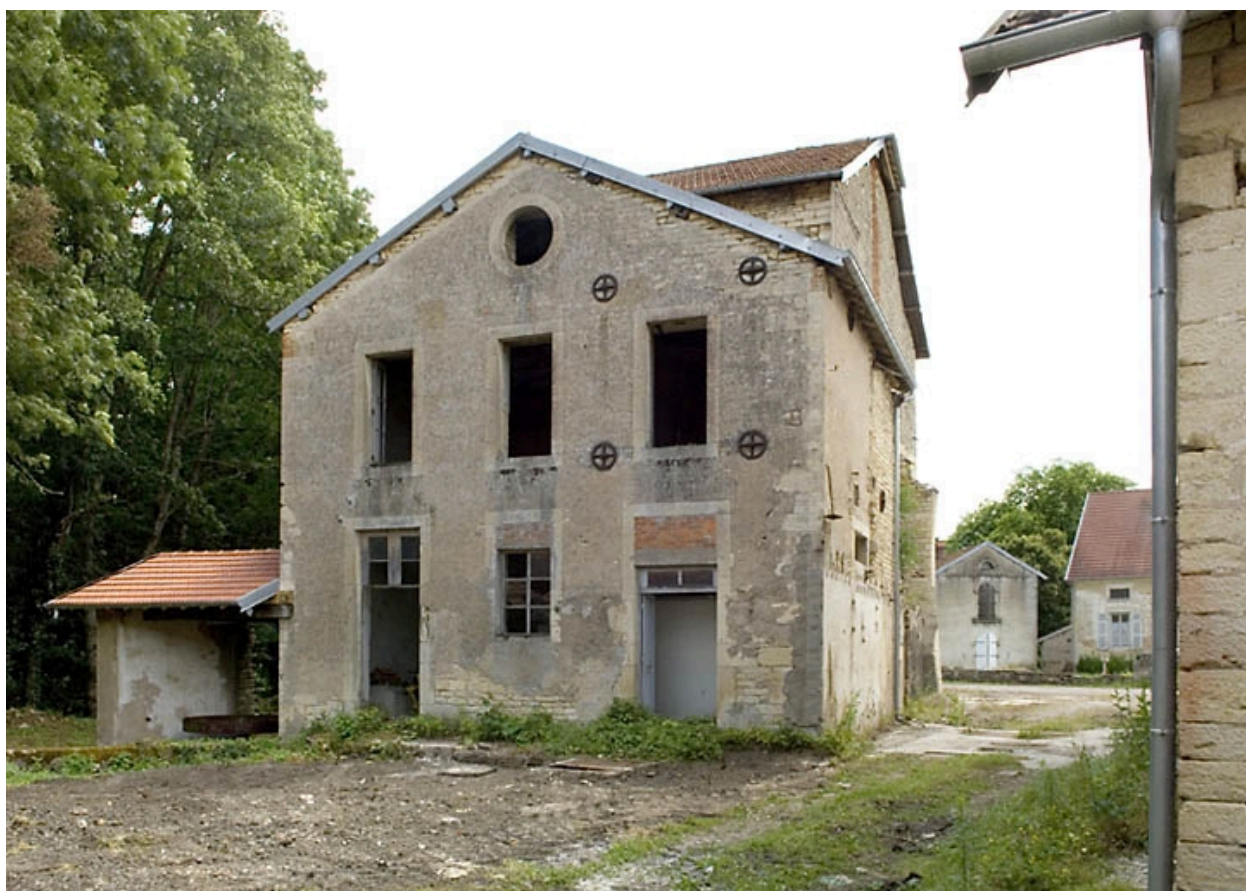
Façade ouest du haut fourneau.
