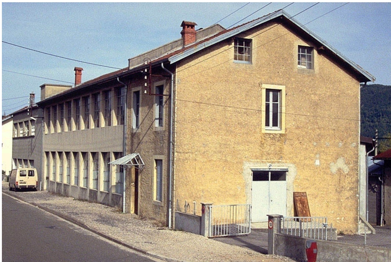
Usine de tableterie (tournerie) de la coopérative la Tournerie ouvrière, Lavans-lès-Saint-Claude (8 rue de la Cueille).
