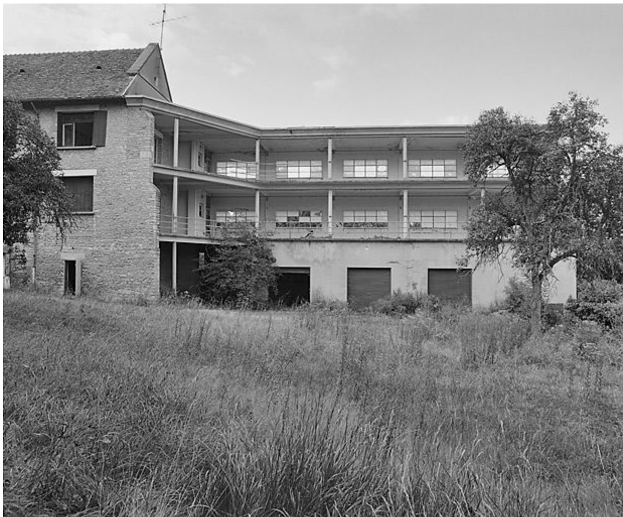
Galerie de cure est, façade sud-est.
