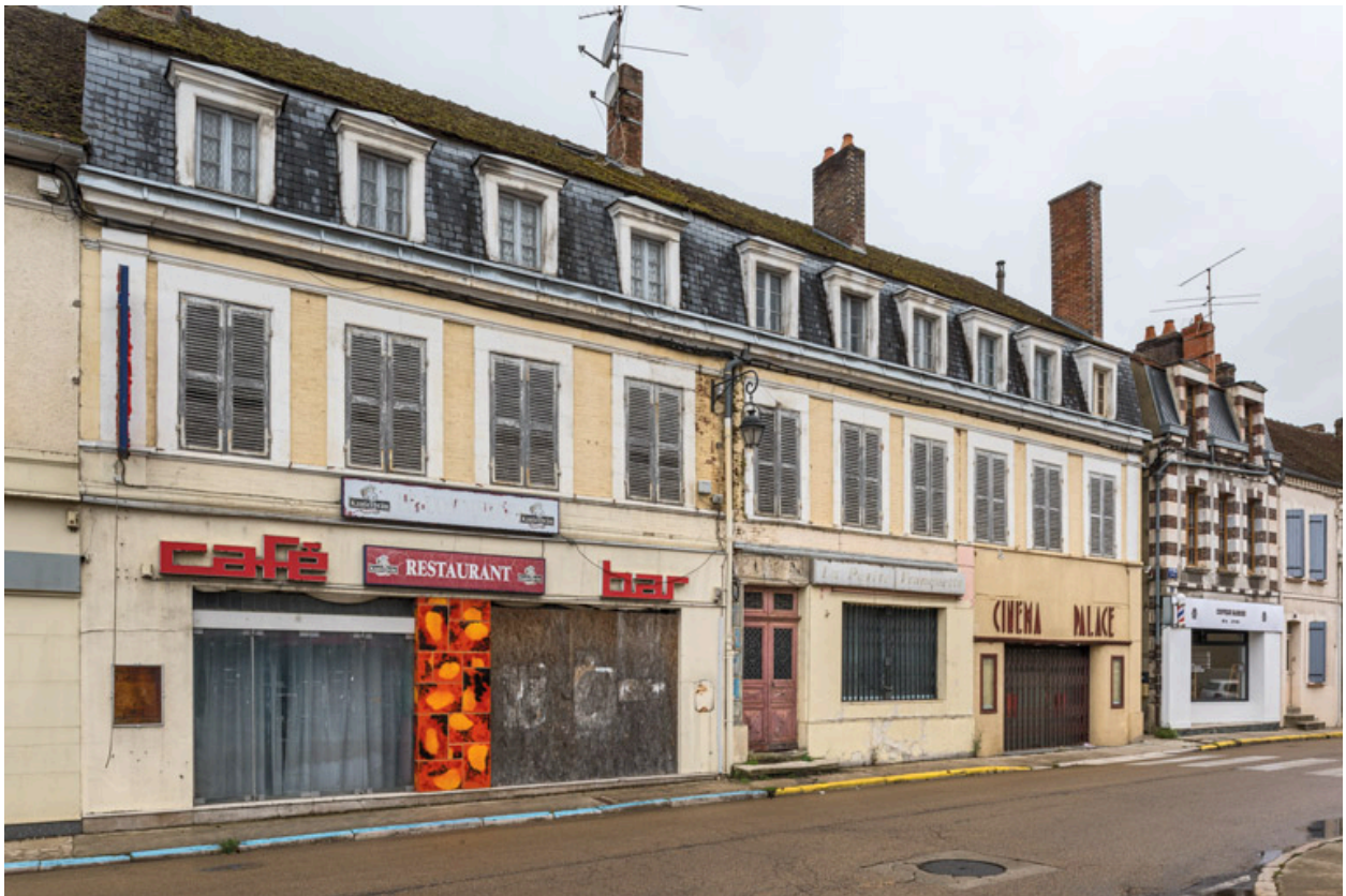
Saint-Florentin, 13 place Dilo : ancien cinéma Palace.
