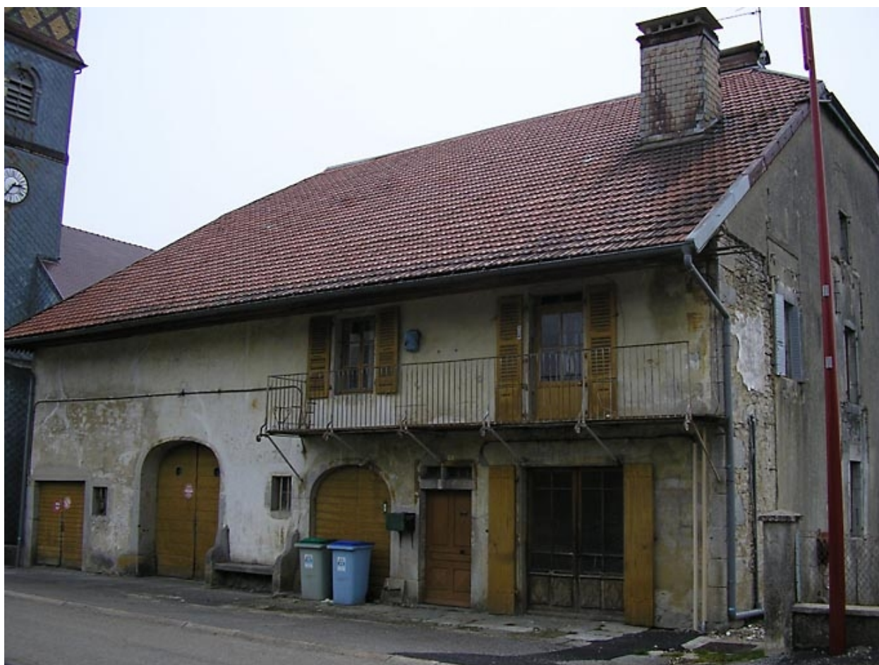
Vue de trois quarts sur façade antérieure.
