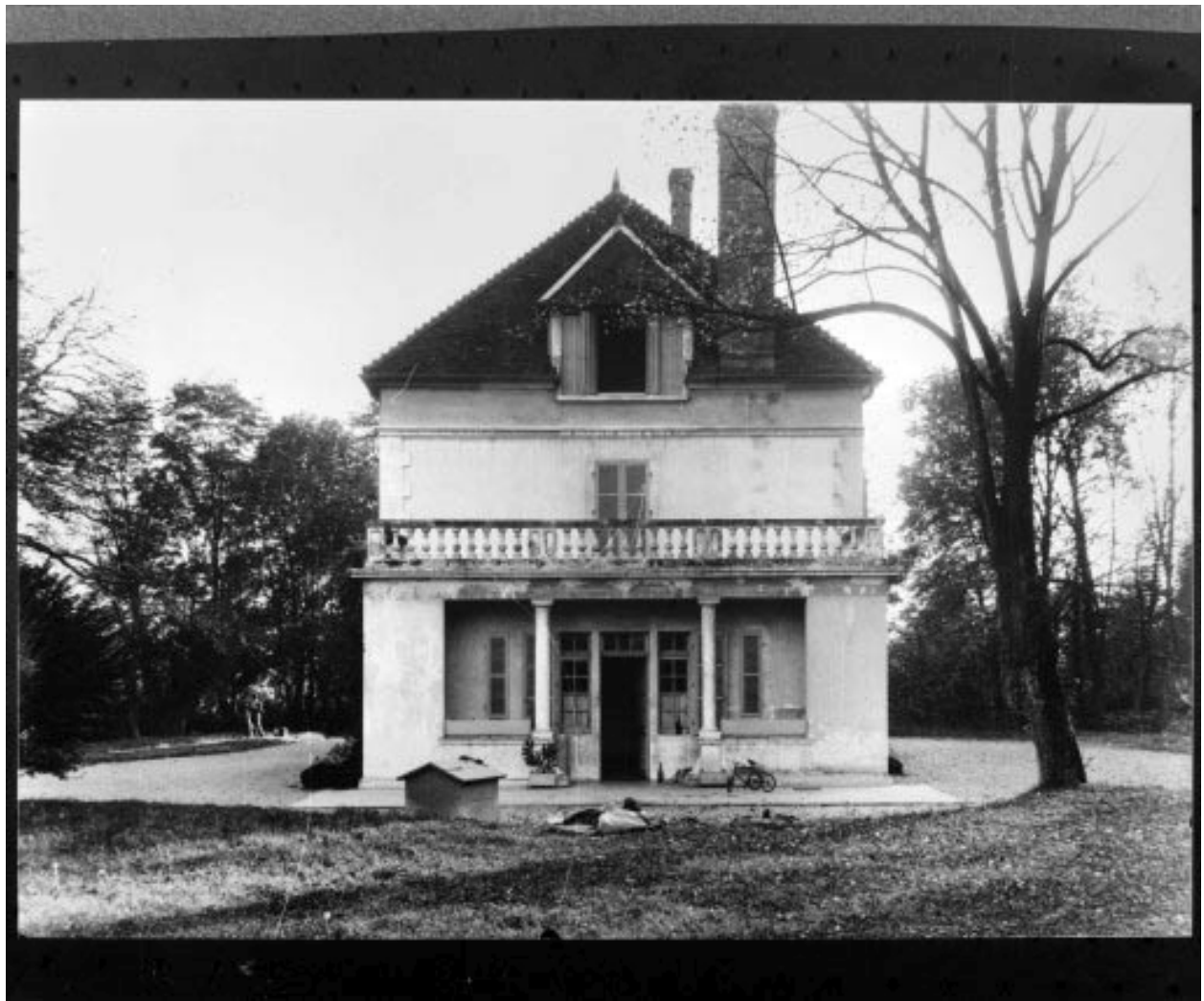
Logement patronal du Clos de Belvove, façade latérale droite.
