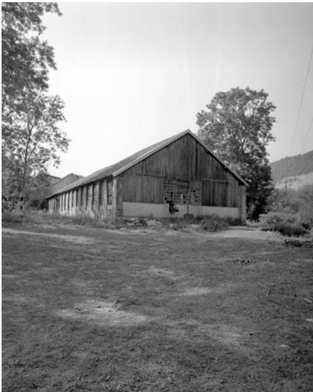
Clouterie vue du nord.
