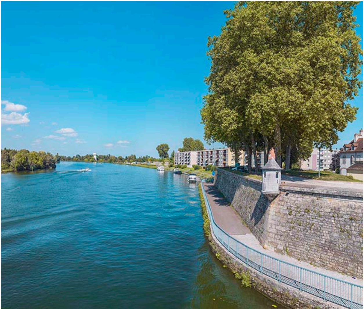
Vue du bastion en amont du pont.
