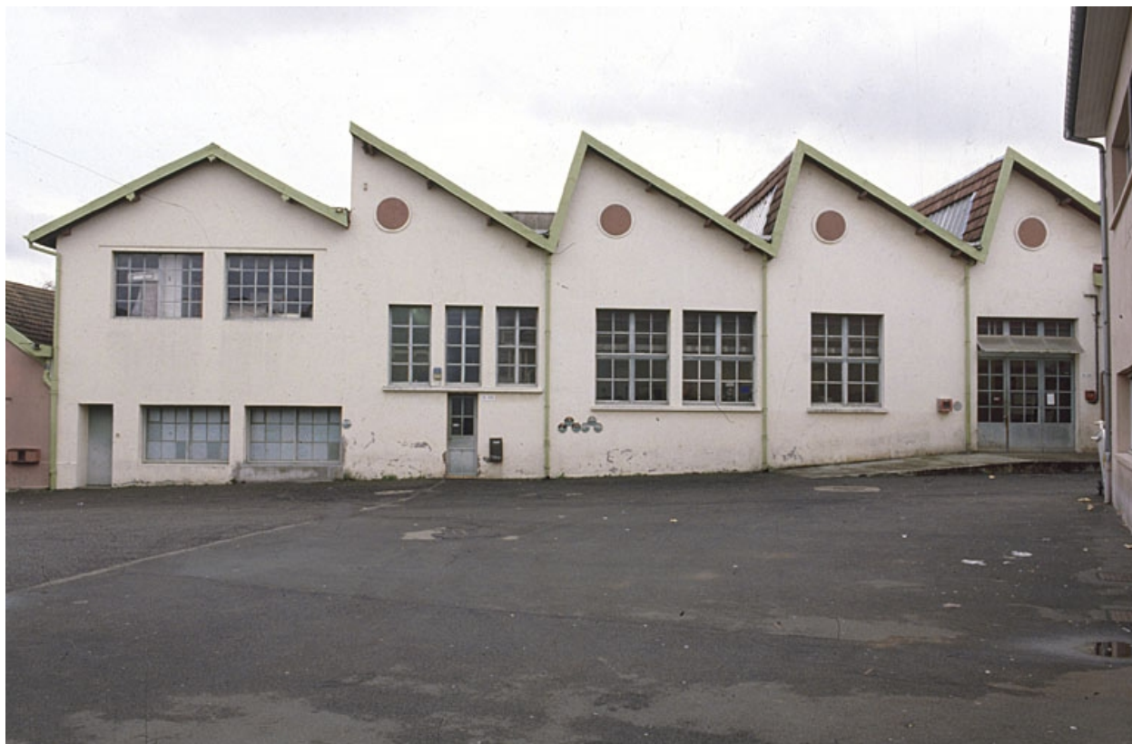
Pignons nord de l'ancien atelier de fabrication.
