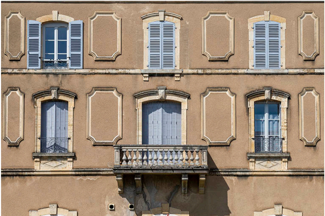
Corps de bâtiment sud, premier étage et second étage, vue de face.
