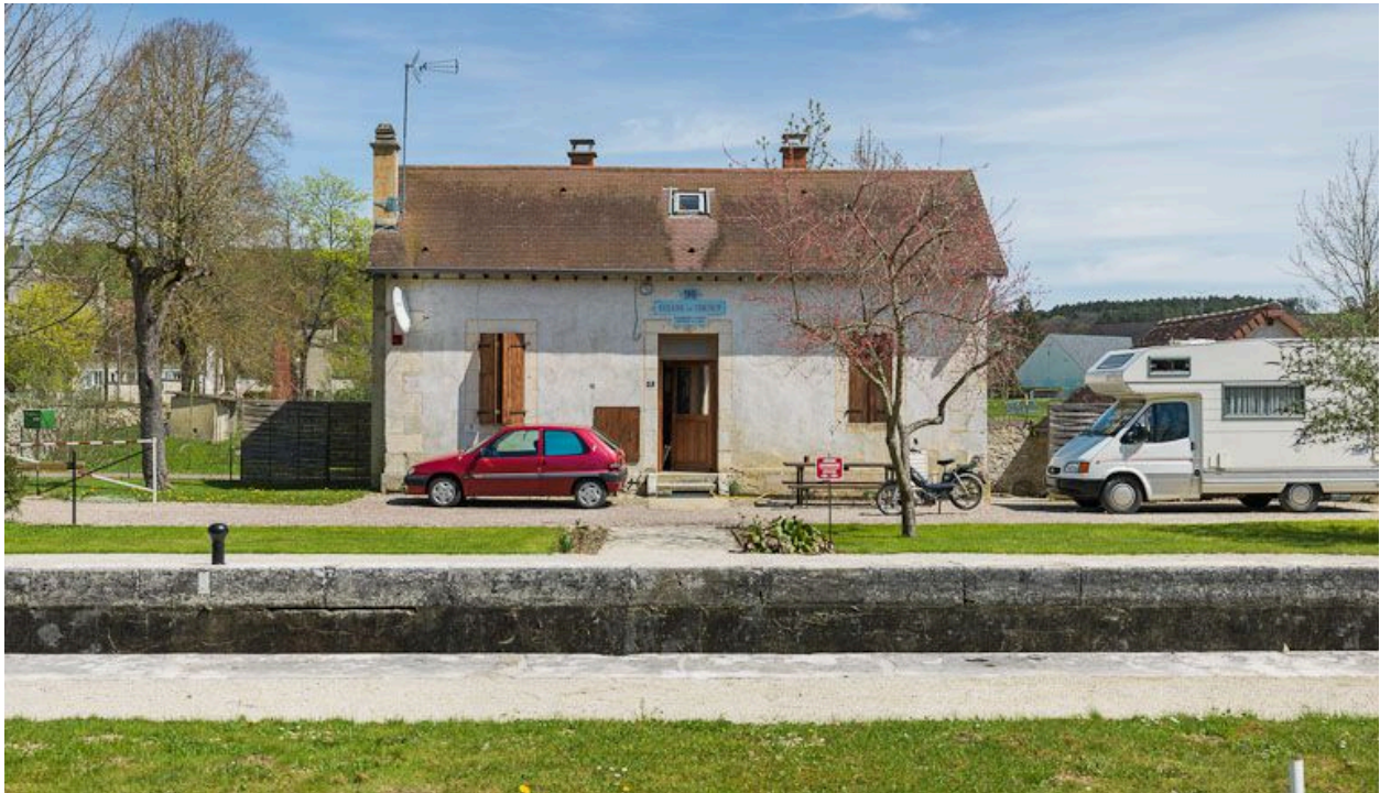
La maison éclusière de face.
