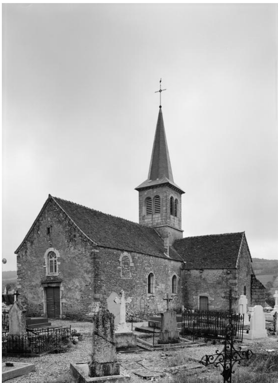
Vue d'ensemble de 3/4 droit.
