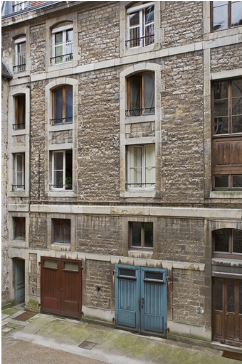
Façade postérieure sur cour : détail de l'aile droite.
