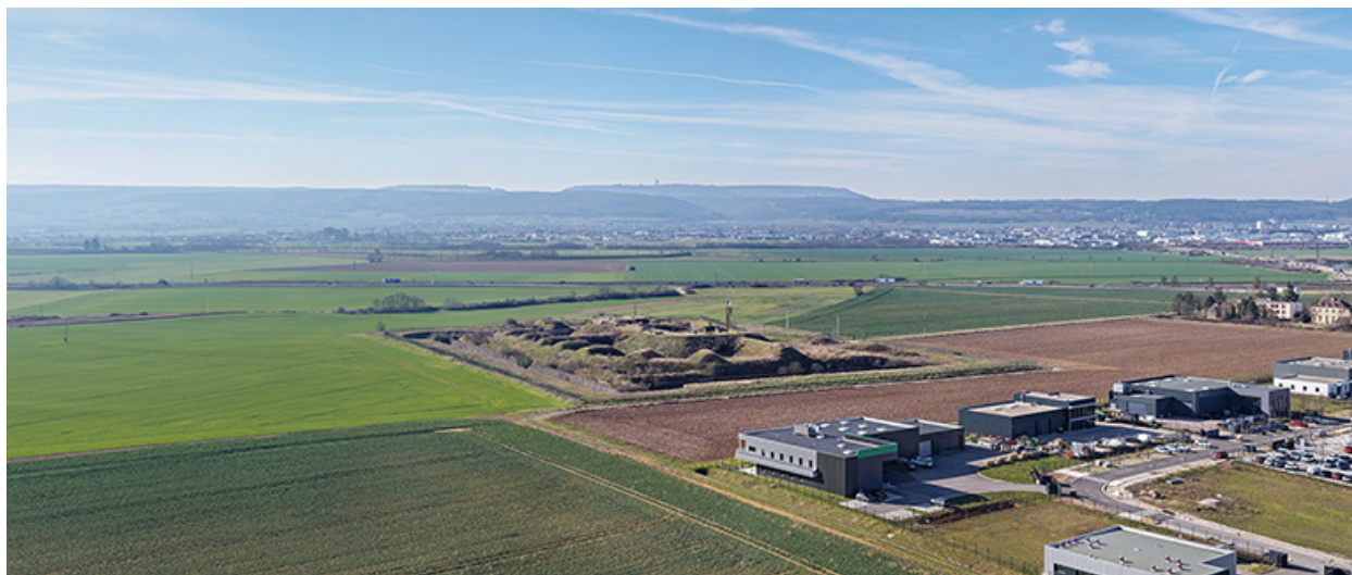
Le fort et le Mont Afrique en arrière-plan. (vue aérienne).
