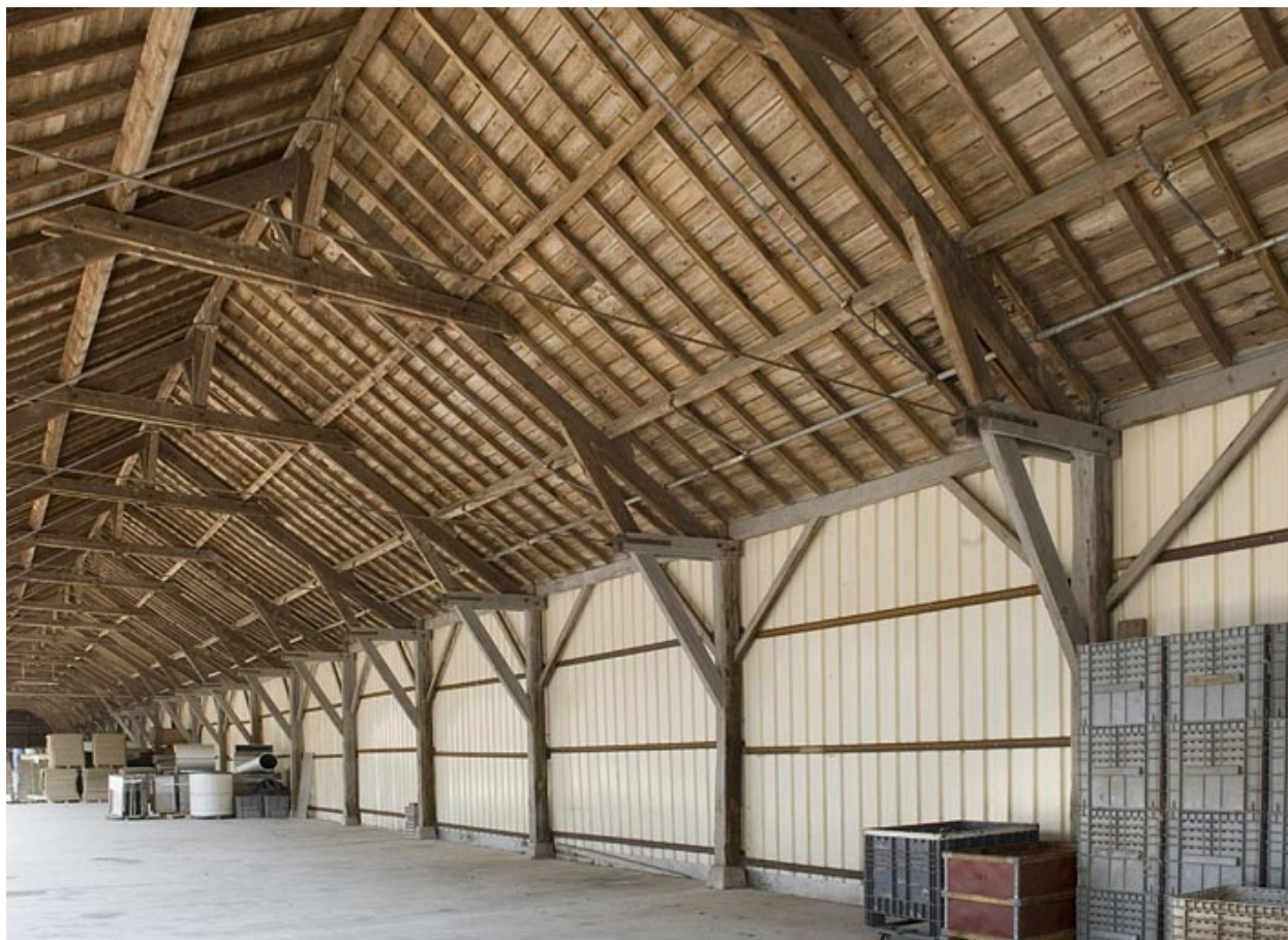
Fermes de la charpente de l'entrepôt industriel.
