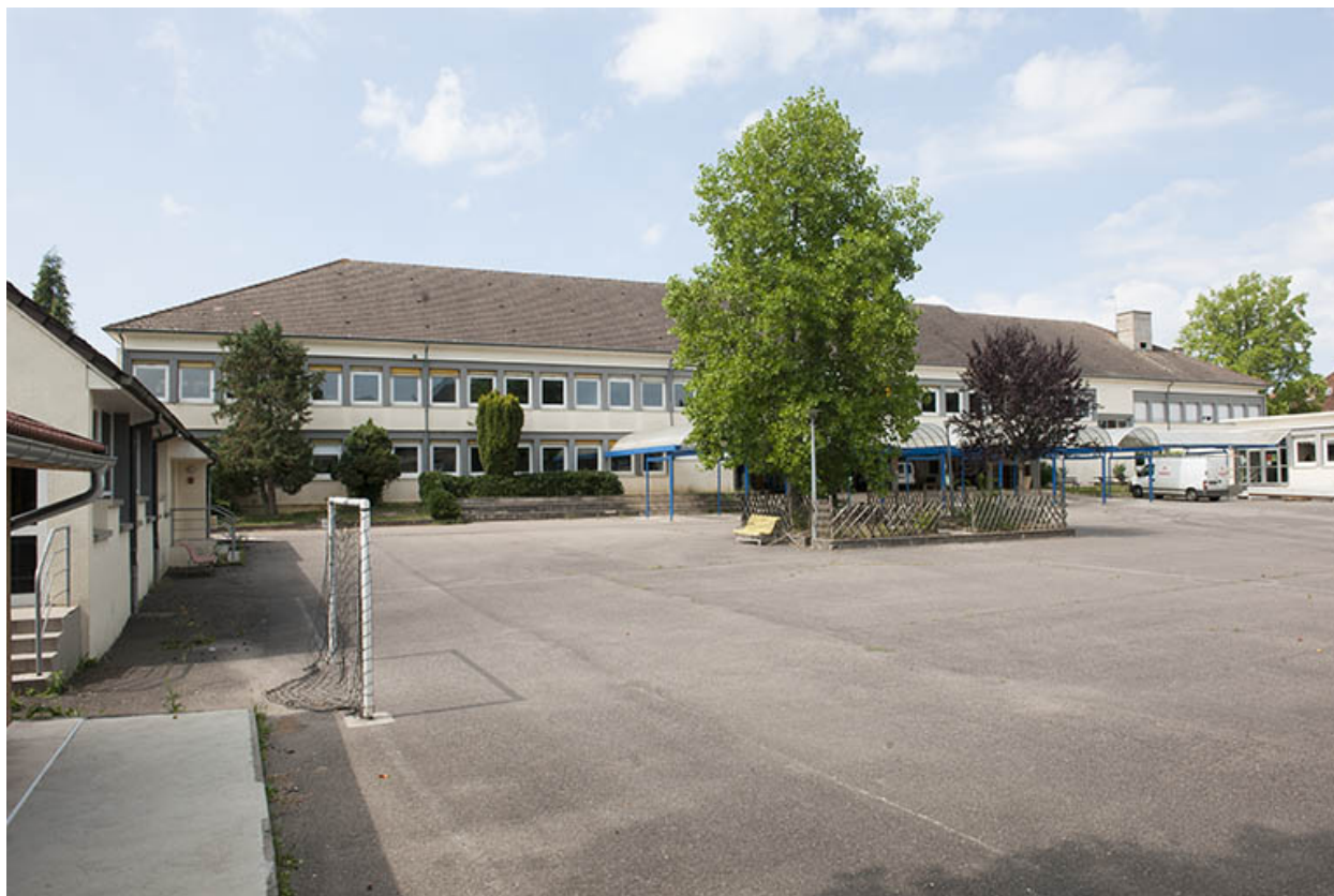
Vue générale sur la cour.
