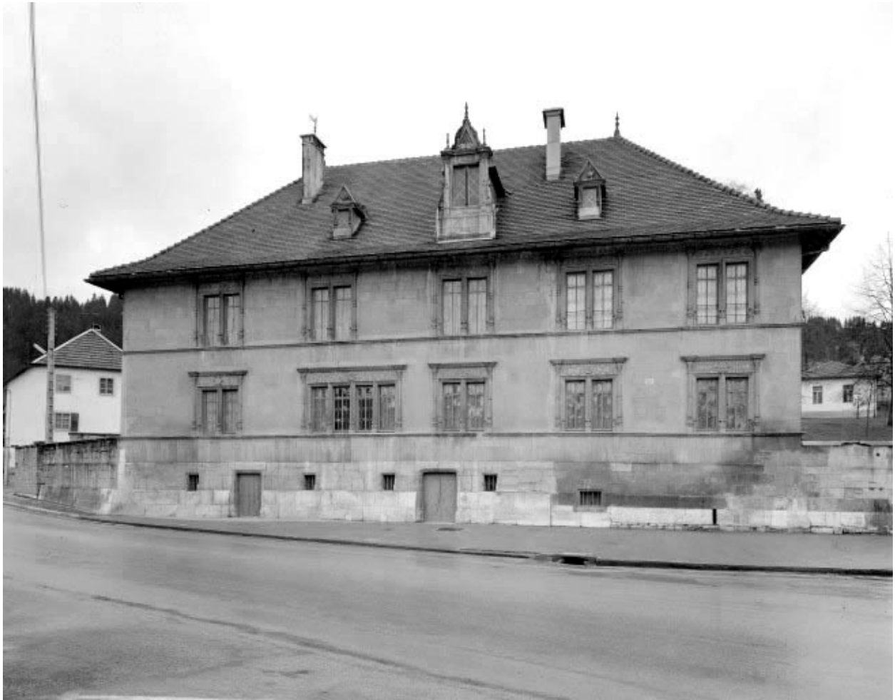
Façade sur rue : vue d'ensemble.
