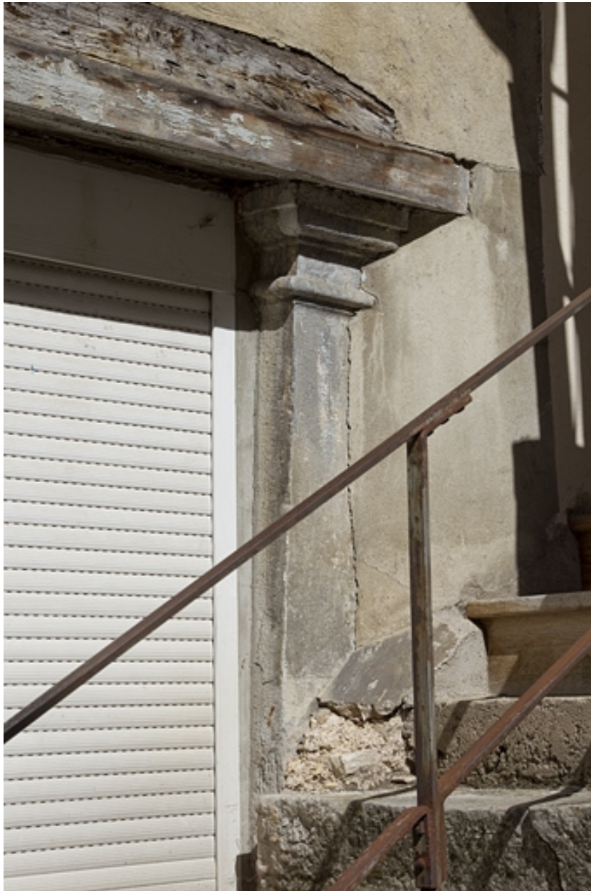
Façade postérieure du premier logis secondaire, vestiges supposés d'un portique : détail d'un chapiteau toscan.
