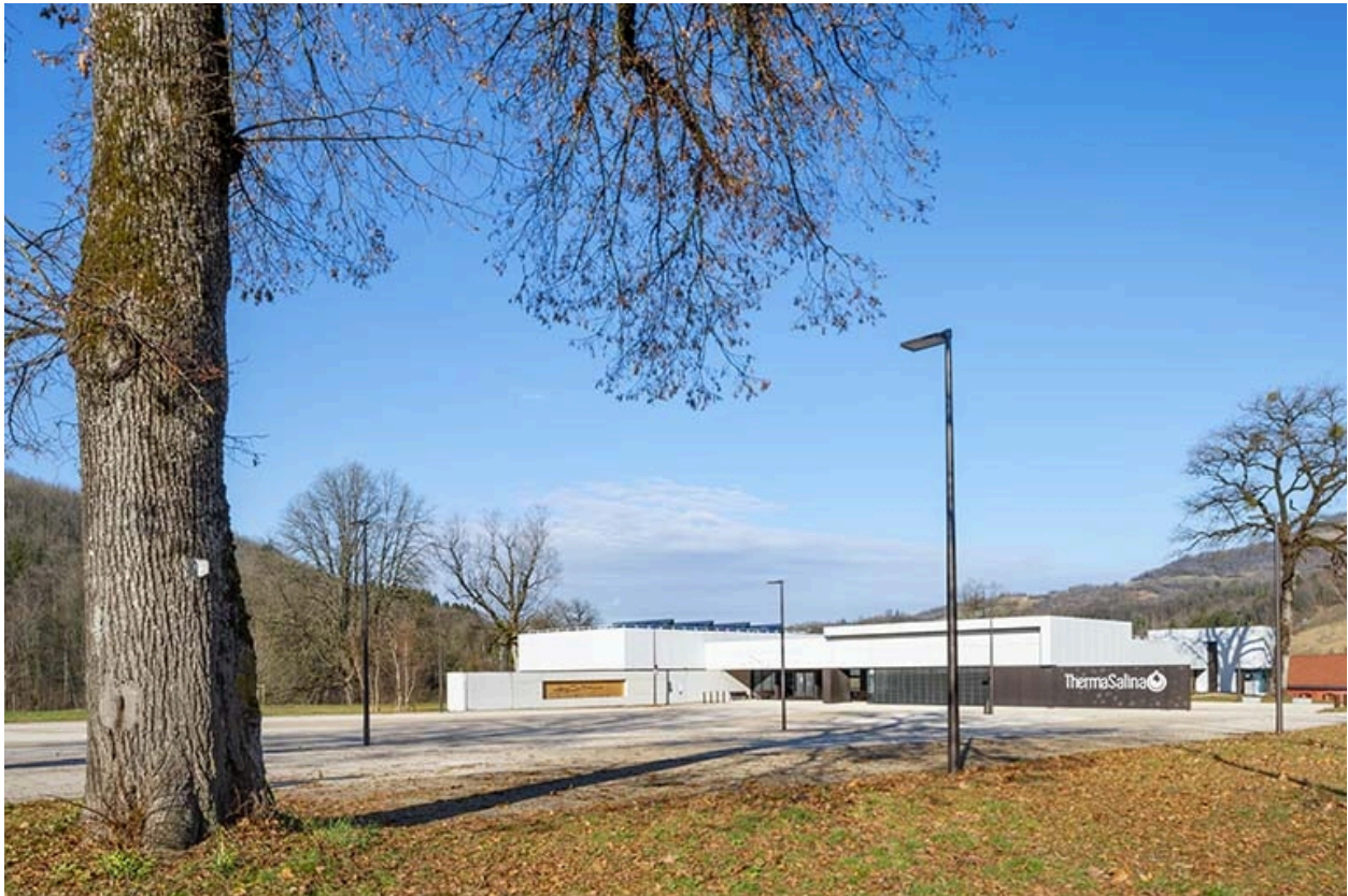
Parc de stationnement au sud de l'établissement.
