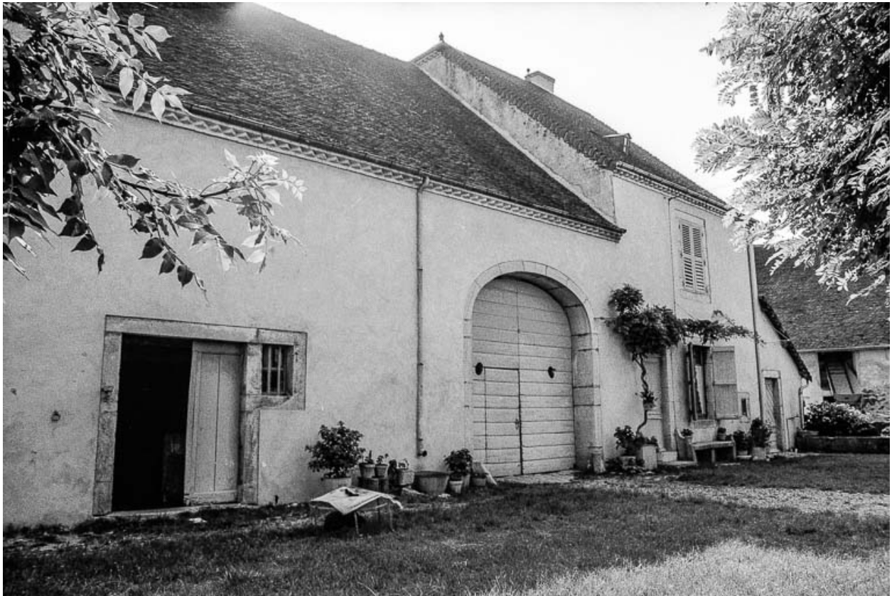
Ferme cadastrée 1960 AE 116, située rue Saint-Aignan : façade antérieure vue de trois-quarts gauche.
