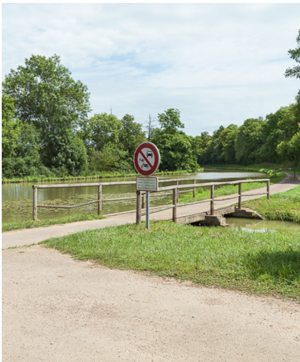
Vue d'ensemble de l'ouvrage.
