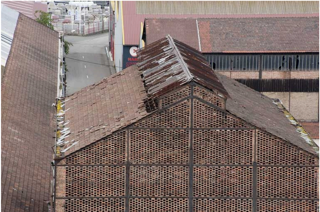
Bâtiment du gazogène. Partie supérieure du pignon est.
