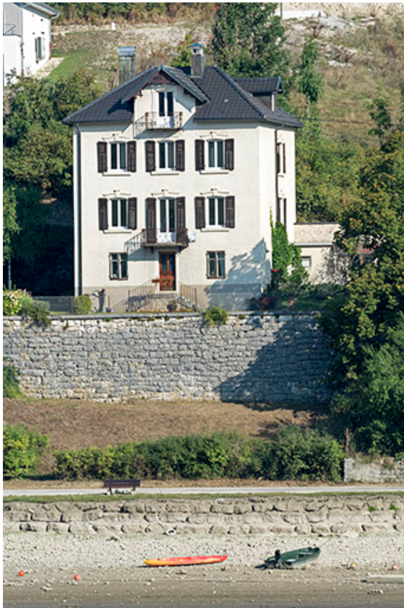
Vue d'ensemble, depuis le sud-est (façade postérieure).
