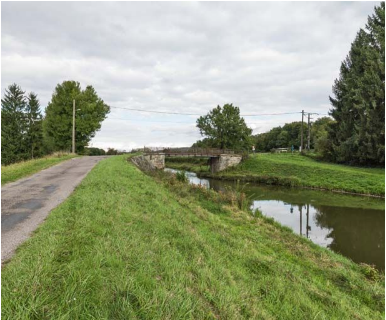
Vue d'ensemble du pont et du site.
