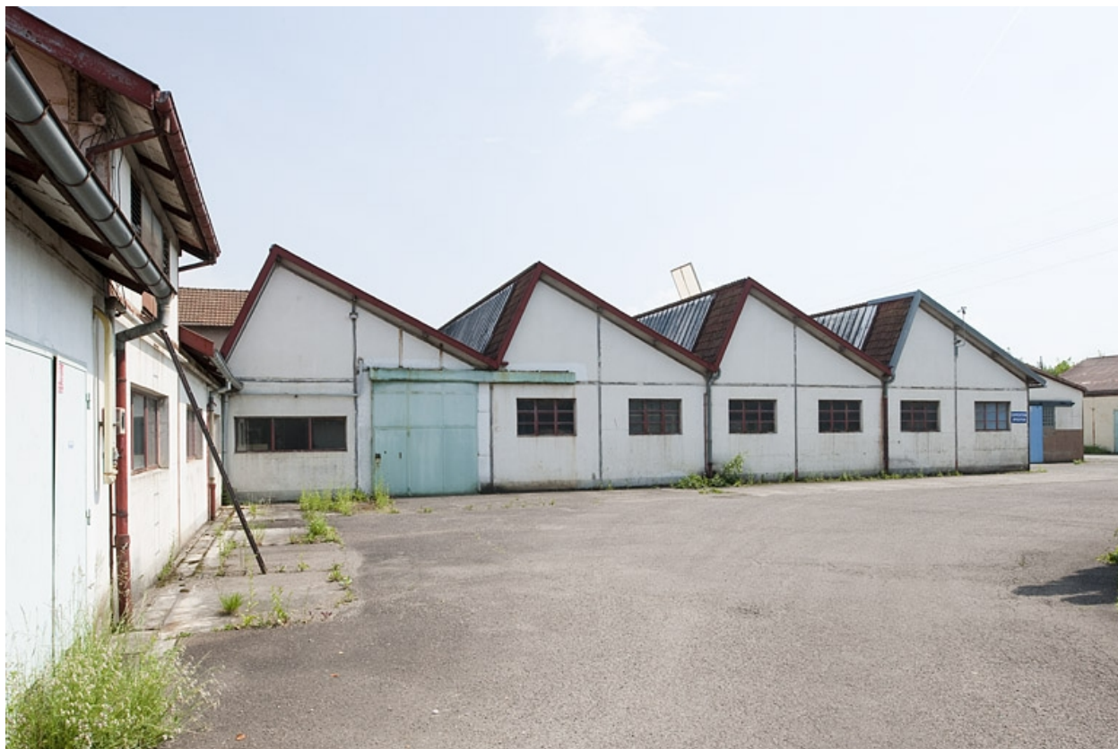
Pignons des shed de l'atelier d'usinage sud.
