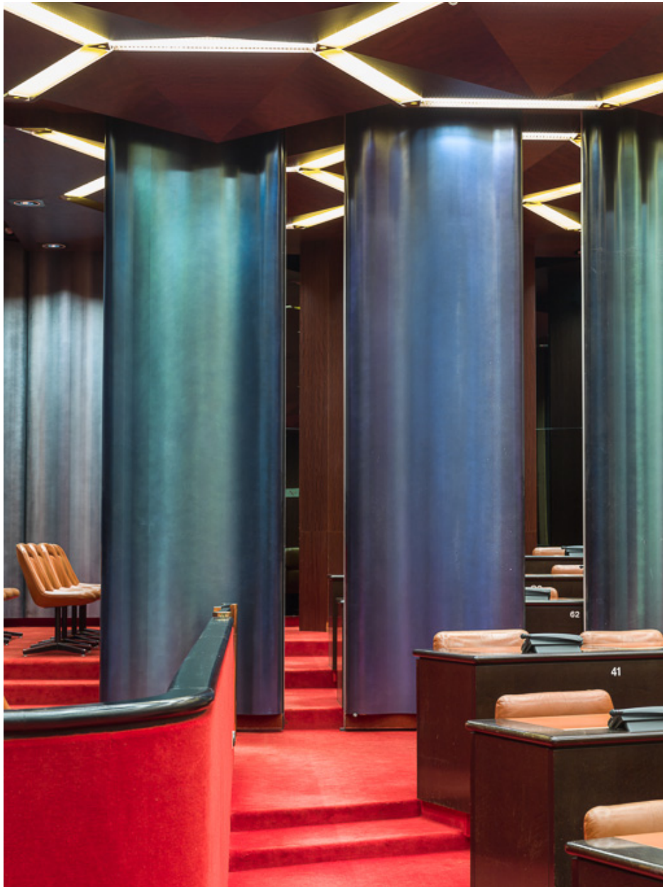
Salle des Assemblées : vue des panneaux de la cloison coulissante de séparation.
