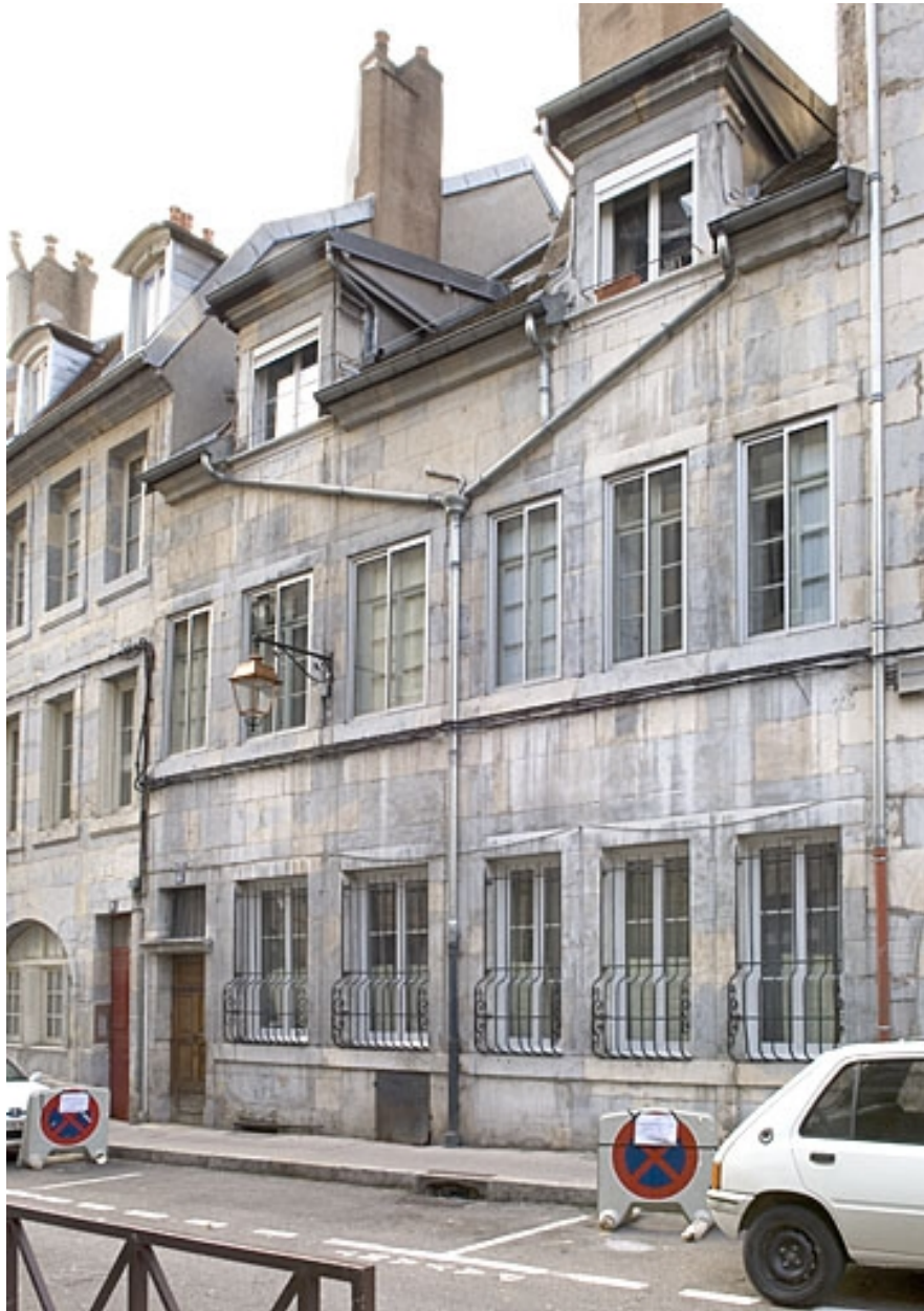
Vue d'ensemble de la façade sur rue.
