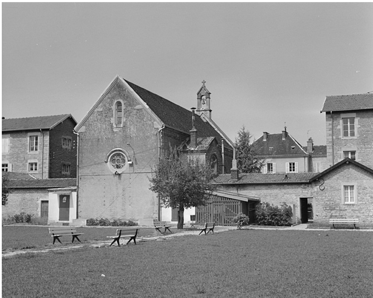
Chapelle, façade postérieure en1983.
