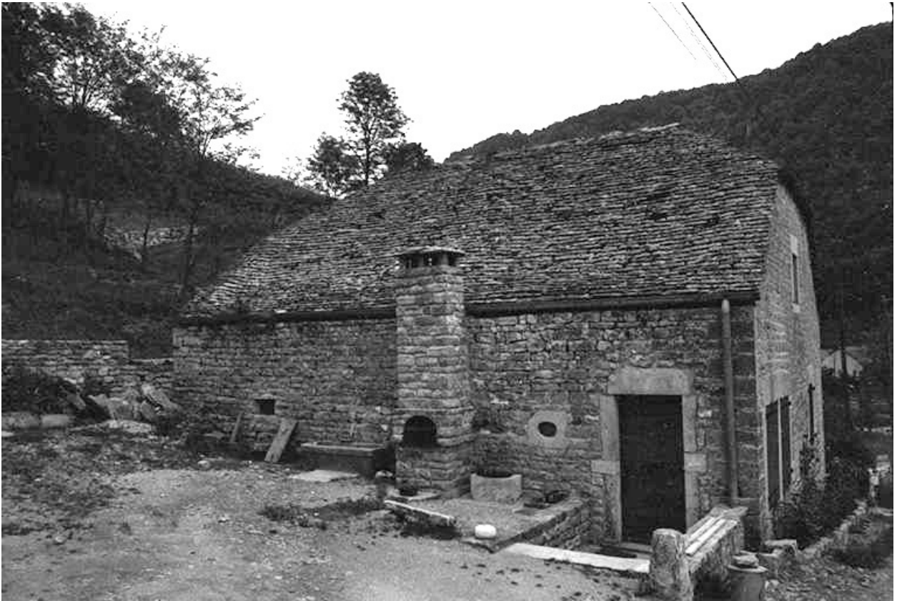
Ferme cadastrée 1960 B 56, située au lieudit La Peyrouse : façade antérieure. A noter le toit de laves.
