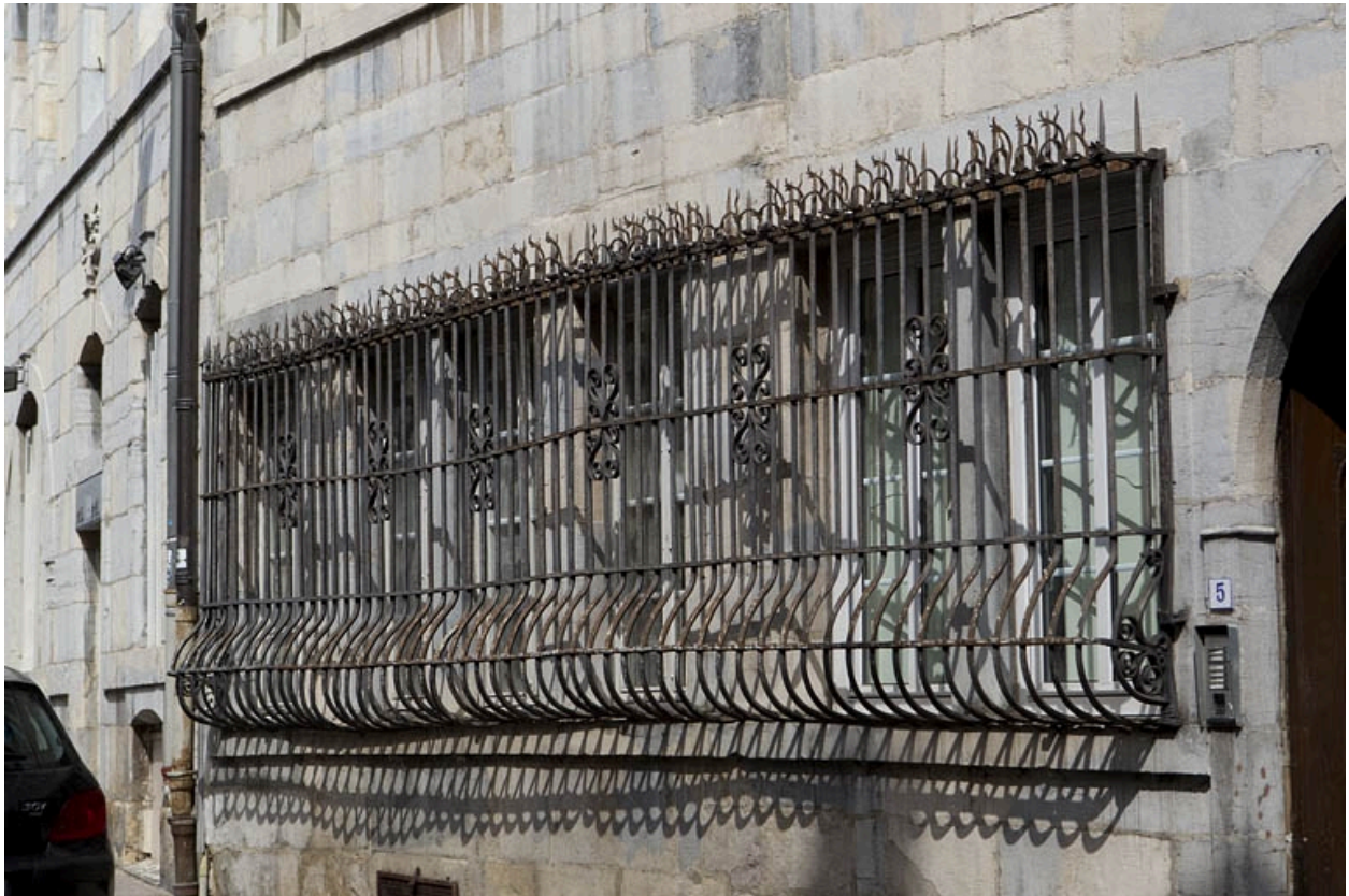
Façade sur rue du logis principal : détail des grilles devant les fenêtres du rez-de-chaussée.
