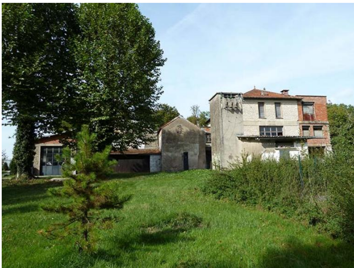
Vue sud de la laiterie
