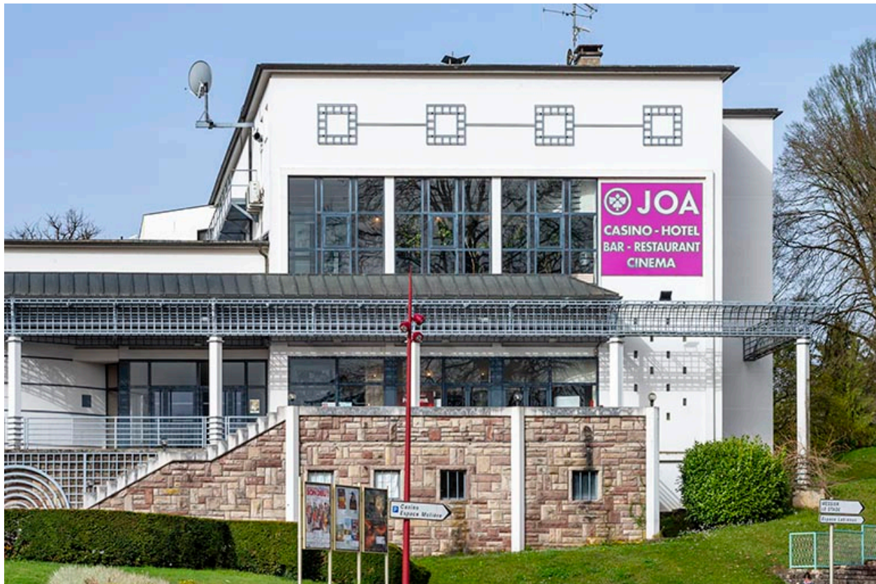
Salle des fêtes, vue depuis l'ouest.
