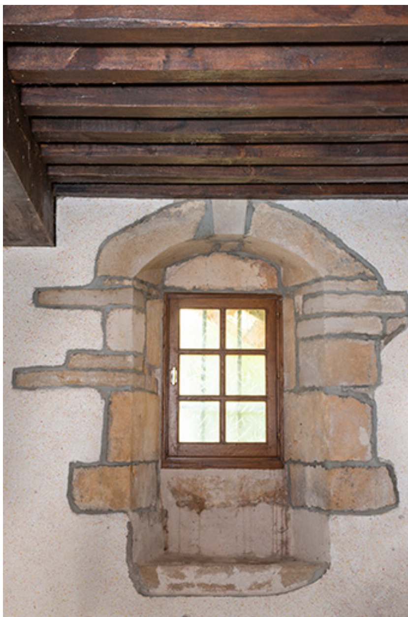
Détail d'une fenêtre, ancienne cure.
