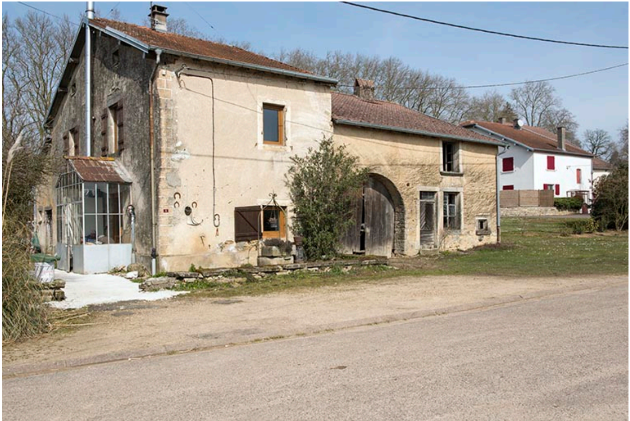
Ferme à Richecourt.
