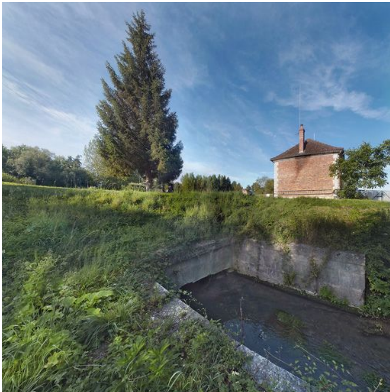
Entrée de l'aqueduc.
