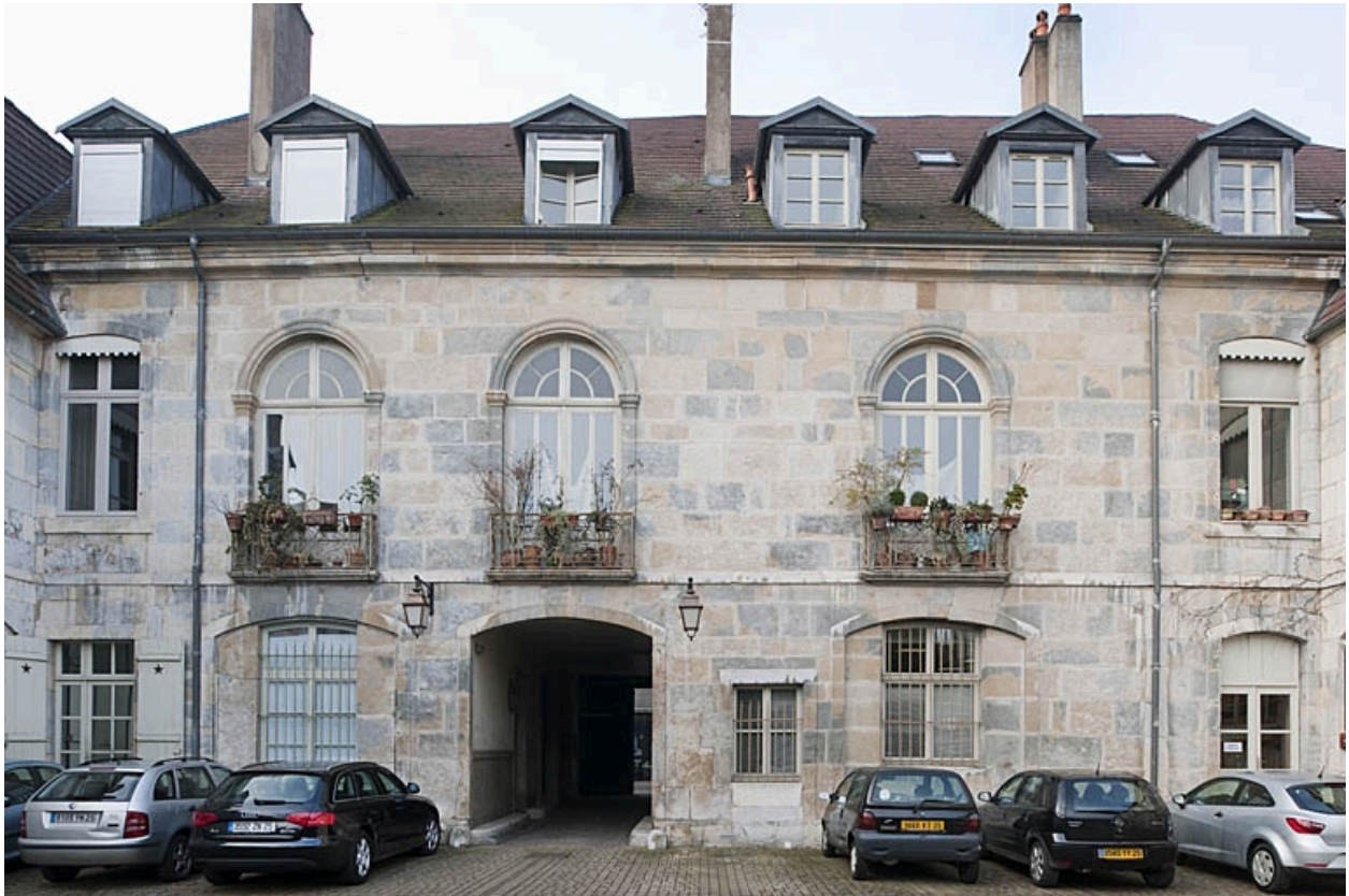
façade postérieure de l'hôtel : de face.
