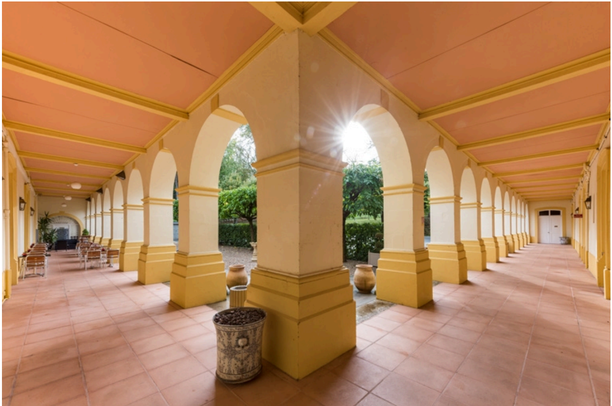
Galleries des ailes de la cour.
