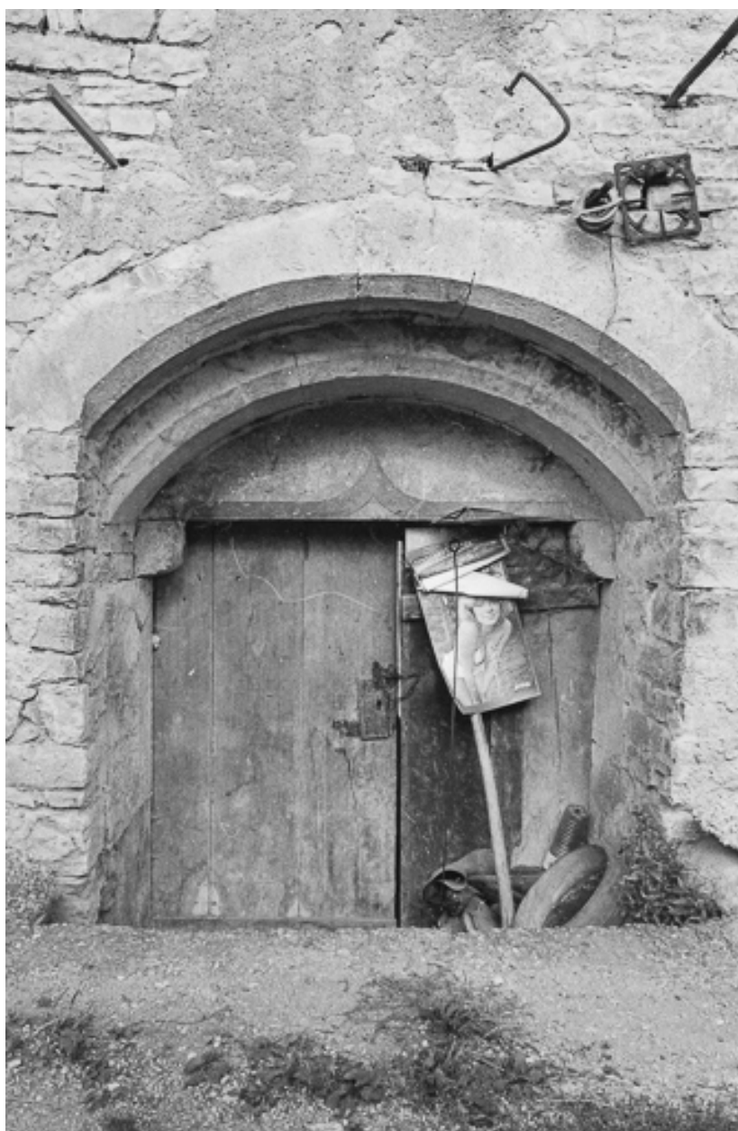
Ferme cadastrée 1973 AB 29 : entrée de cave.
